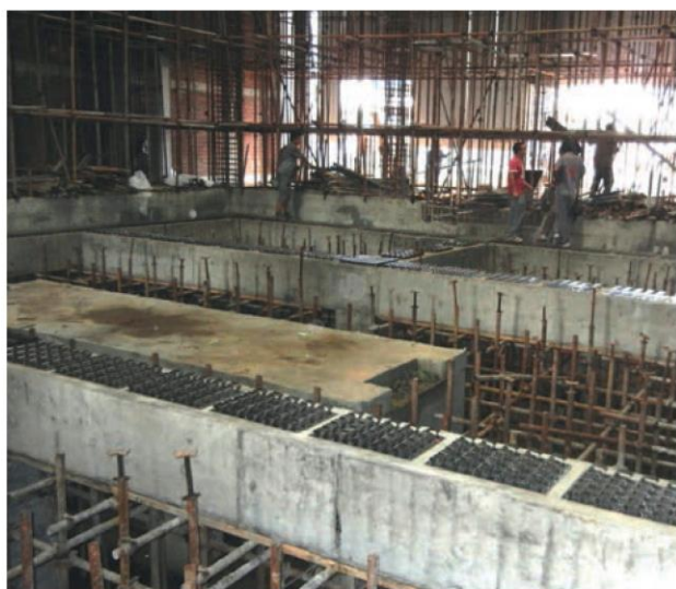
Пружинные опоры, устанавливаемые для системы плавающего пола
