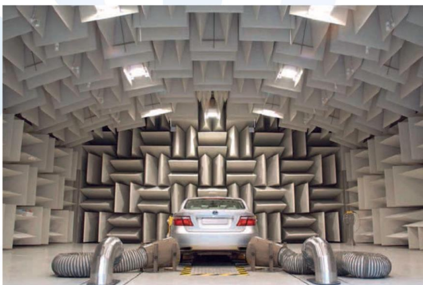
Тот же объект после завершения возведения камеры и установки клиньев
