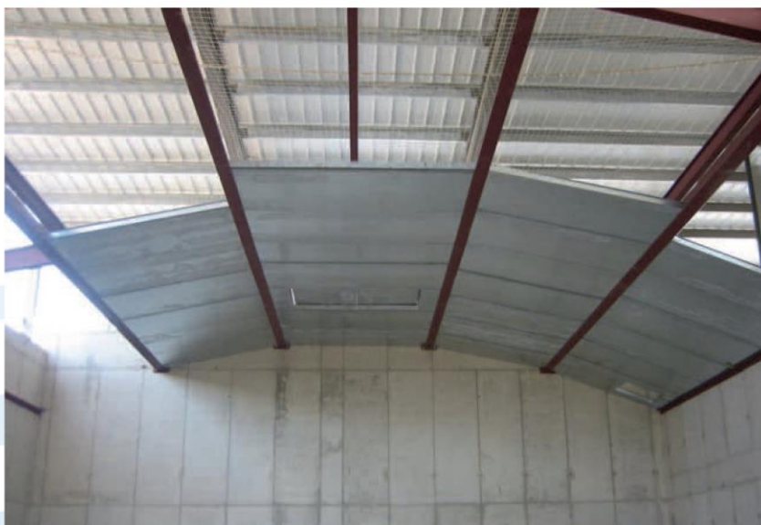
Полубезэховая камера с арочной крышей на этапе возведения
